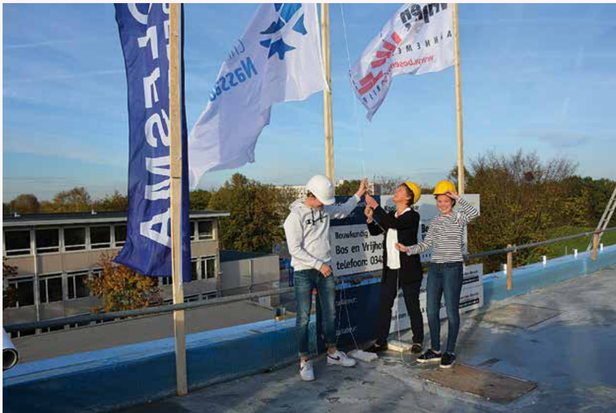
Op 21 oktober 2018 werd het hoogste punt bereikt van de nieuwbouw op de gymzalen, die vooral gebruikt wordt door leerlingen van de Bizz-school en de Theaterhavo.
